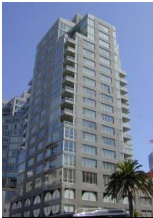
Рис.5. Фасад здания в Калифорнии (США). Жесткая рама использована как архитектурный элемент.
