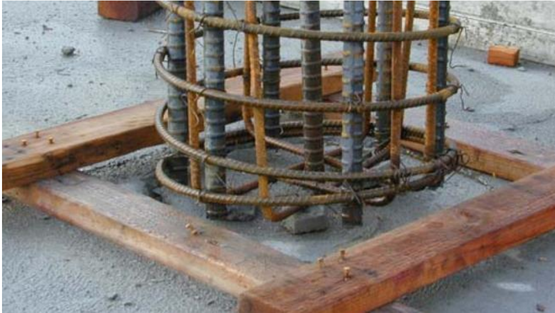
Рис.4. Шарнирный узел соединения колонны и перекрытия
