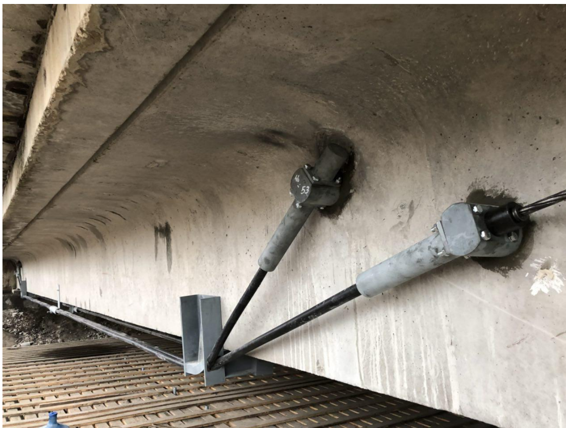
Рисунок 5 - Усиление мостовой балки канатами в полиэтиленовой оболочке
